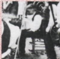
Sur la photo du bas de page on voit, à droite, un métier qui semble n'avoir que 6 têtes. L'ouvrier termine le point de pied de bas noirs de qualité car on distingue les rangs de fil blanc qui délimitent le revers de cuisse. A l'angle droit inférieur on voit une pile de bas noirs terminés qui vont passer dans les ateliers de femmes. Les pointes et les talons seront remaniés puis ils seront cousus sur des couseuses à cuvette dites couseuses grecques.
