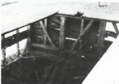
Un bassin au sol, dans lequel se reflète la charpente du bâtiment. Vallentigny (A).
