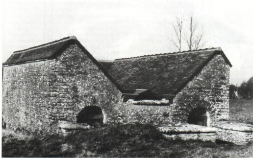
Les toits alimentent en eau de pluie, le bassin de Lantages (A).
