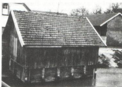
A Villacerf, les panneaux inférieurs sont en place, pendant la mauvaise saison.
