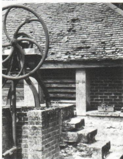
La pompe d'alimentation du lavoir de Vauchonvilliers (A).
