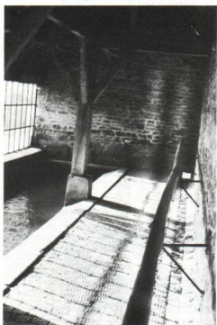
Une barre d'égouttage au-dessus de la rigole du sol.
