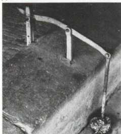
A La Rothière (A), bonde qu'on manœuvre à l'aide d'une poignée articulée.
