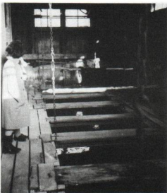
Les chaînes de levage du plancher au lavoir de Jeugny (A).
