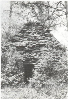
Une « loge » route de Gyé à Essoyes.
