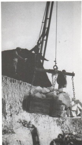
La benne monte, tirée par le câble du treuil
