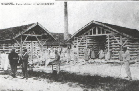
Bassins et séchoirs. Cheminée du four
