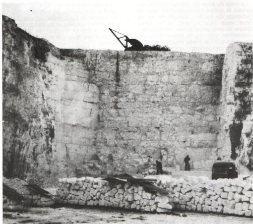
Front de taille. Fin d'un chantier
