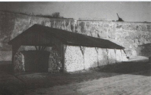
Le hangar, le front de taille, le treuil, un tas de séchage en haut, un autre en bas
