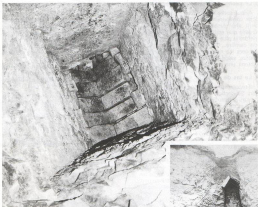
De l'intérieur d'une galerie, vue prise vers le haut, de la fermeture d'un essort condamné
