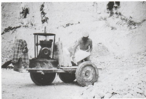
La benne monte, tirée par le câble du treuil
