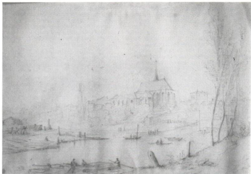
Brelle en construction et bateau sur la Marne à la Noue
