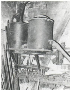
Soufflet métallique. La Perrière. Cne de Maraye-en-Othe.
