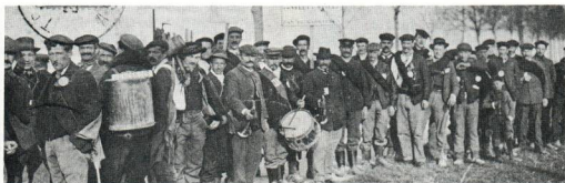
Le cantonnement à Vaudes.
