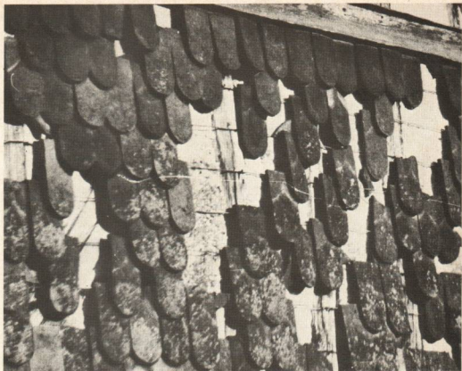
Tuiles de protection sur un mur. Arrembécourt (10).
