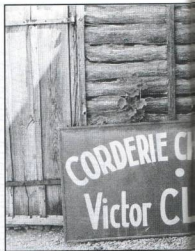
Ancien bardage horizontal en dosses - Pinoy (10)
