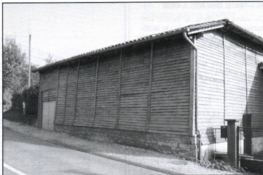
Tavillonnage à clin et couvre-joints serrés - Radonvilliers (10)
