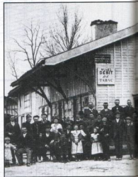
Clins et couvre-joints serrés - Région du Der
