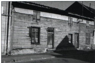
Bardage horizontal à joints vifs - Brienne-le-Château (10)
