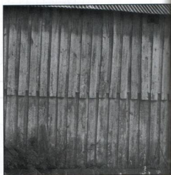
Détail du bardage
