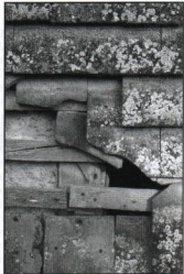
Détail du bardage en tuiles plates
