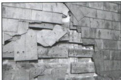
Détail du bardage d'ardoises
