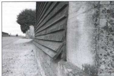
Détail de la base du tavillonnage
