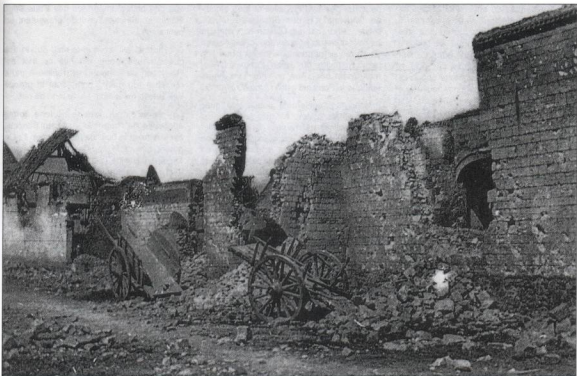
La rue principale de Neuville en ruines
