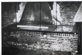
Passage des carretets sur la plaque de fonte chaude pour le redressage.
