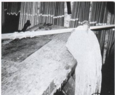
Effilage au rabot de la tige d'une queue à vis par M. René Bardin.
