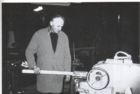
Machine-outil destinée à donner au carretet sa forme conique.
