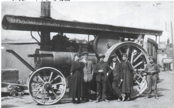
La "routière Aveline-Portier".
