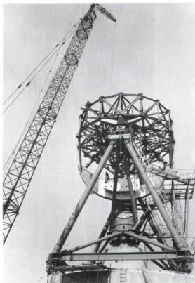
Installation d'une antenne parabolique
