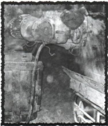
Le roulage : Locomoteur et caisses chargées à la sortie de la galerie principale.
