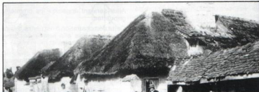
Couverture en losse (Hte Marne) et en chaume (Aube)
