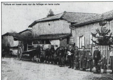
Toiture en losse avec épi de faîtage en terre cuite
