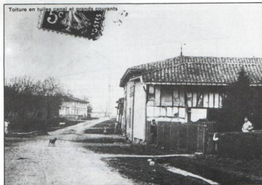
Toiture en tuiles canal et grands courants
