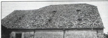
Couverture en losse (Hte Marne) et en chaume (Aube)
