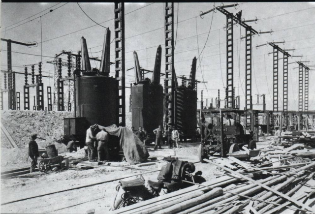
Mise en place du 220 KV le 13-5-1935
